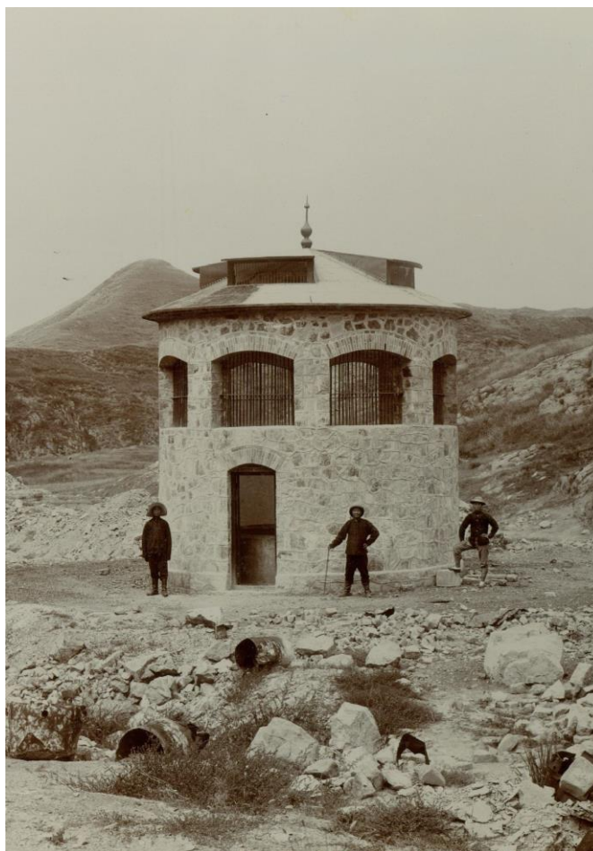
Tour de ventilation ronde, située sur le conduit du tunnel de Badaling, sur la ligne de chemin de fer de Jing-Zhang (ou Pékin-Zhangjiakou), 1909 © WikiMedi Commons.
